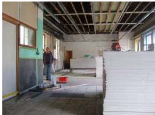
Visite du chantier du nouveau local par notre président Jeannot.
